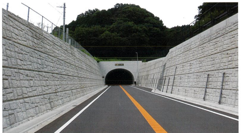
見坂トンネル
