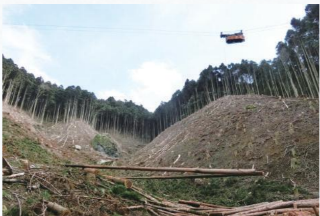
架線集材の様子
